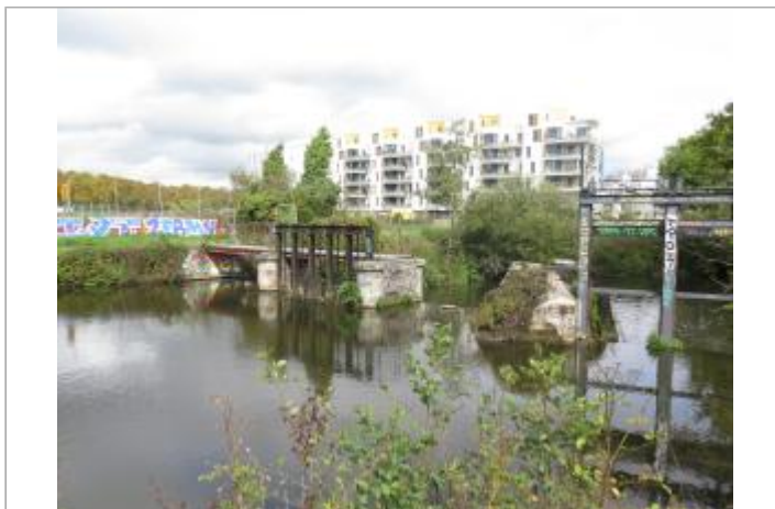
Vannage Trublet en septembre 2017
