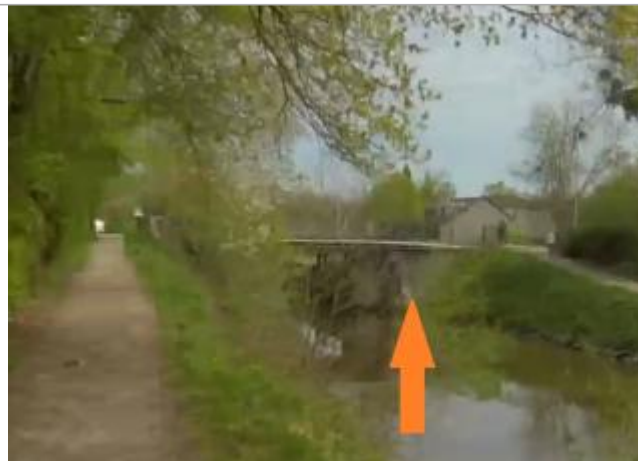
Pont en aval de l'écluse de Robinson à Saint-Grégoire
