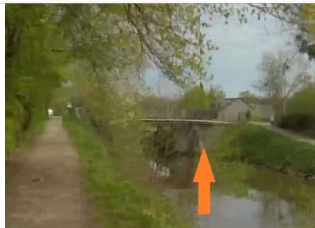
Pont en aval de l'écluse de Robinson à Saint-Grégoire
