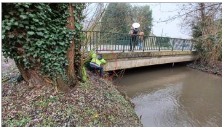
Laisse de crue à 29 cm/bas du tablier du pont.
