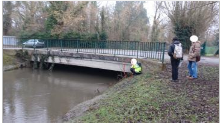
Vue depuis le chemin piéton en aval du pont.
