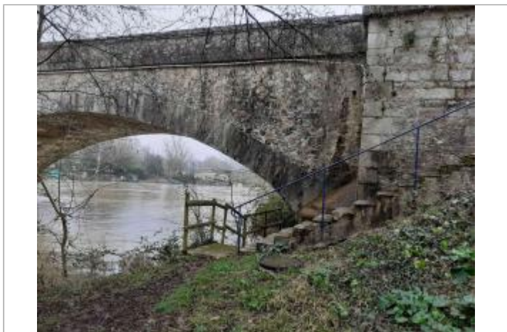
vue d'ensemble du site, sous le pont
