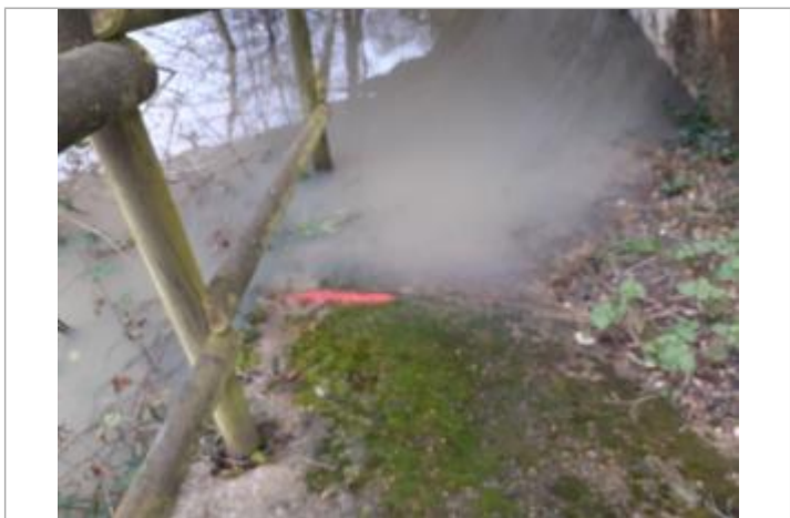
marque au sol : niveau de l'eau au moment du repère
