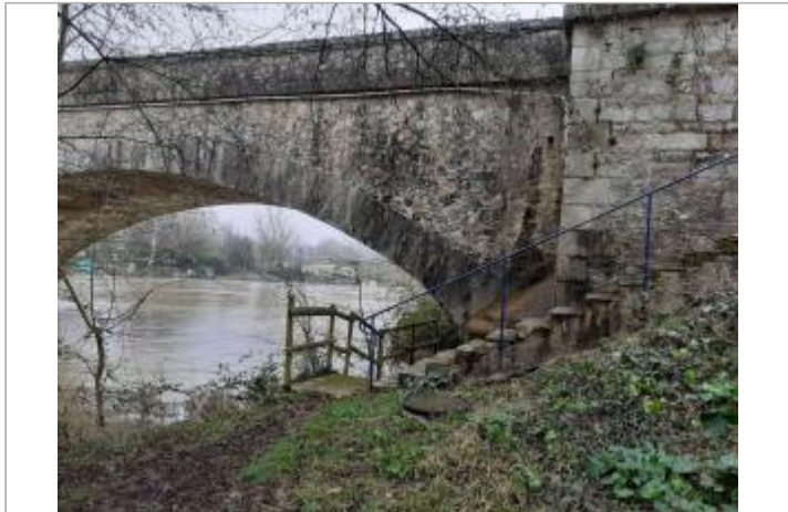
vue d'ensemble du site, sous le pont
