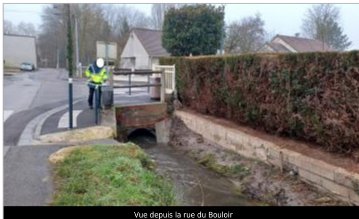
Vue depuis la rue du Bouloir
