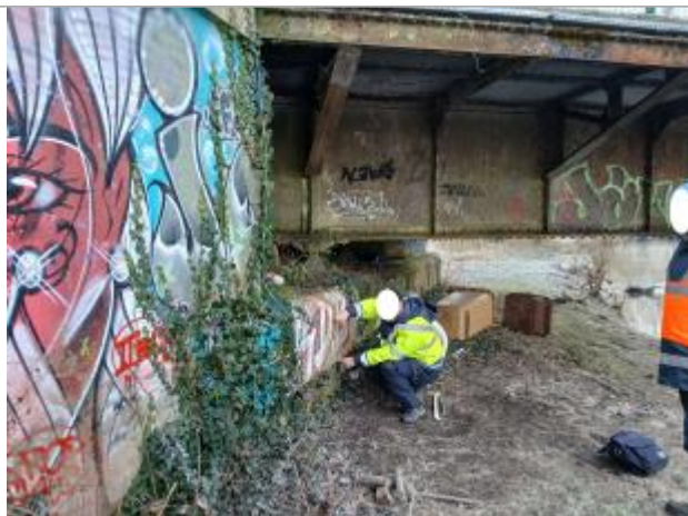
Laisse de crue à 3 cm/rebord du mur.
