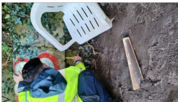
Laisse de crue à 1.5 cm en dessous/rebord du mur.
