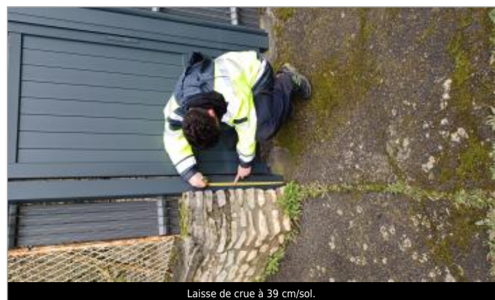
Laisse de crue à 39 cm/sol.
