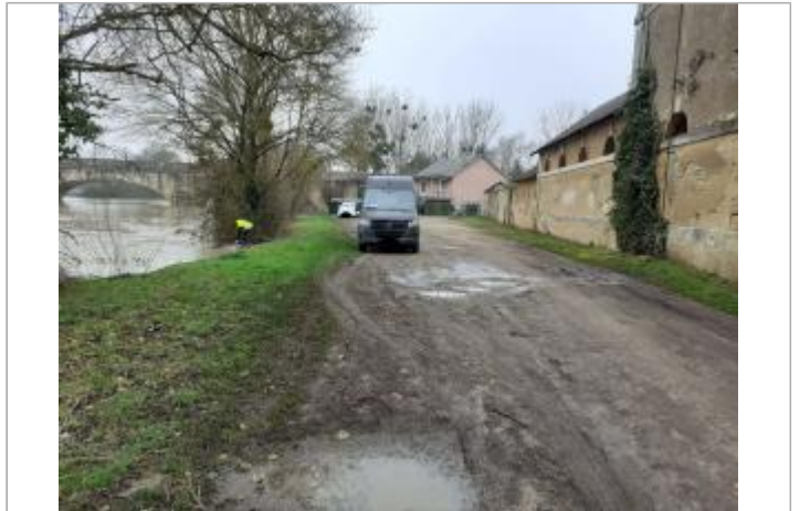
vue d'ensemble du site, proche du Loir
