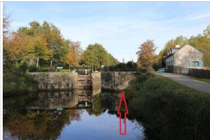
bajoyer aval (échelle limnimétrique disparue) de l'écluse de Charbonnière à Saint-Grégoire
