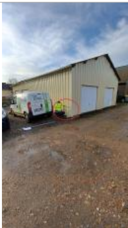
Laisse de crue à 51 cm/sol
