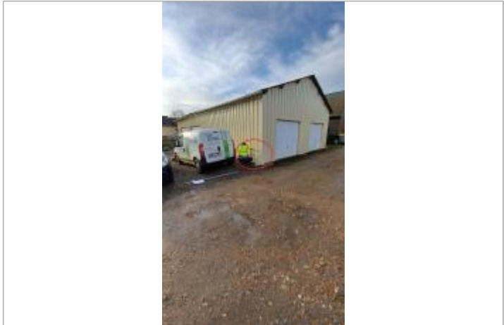
Laisse de crue à 51 cm/sol
