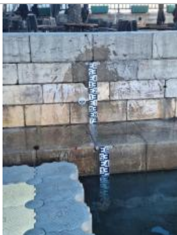
Repère et échelle de crue au droit de la statue
