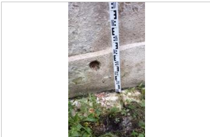
Vue sur le point de la mesure
