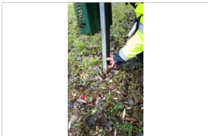
Vue sur la marque d'inondation laissée sur le poteau
