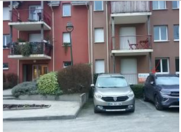
vue générale du site - situation du balcon par rapport à l'entrée du bâtiment C
