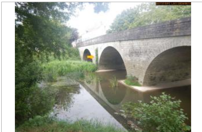
Vue du site en 2024, avec le repère de la crue de janvier 2018
