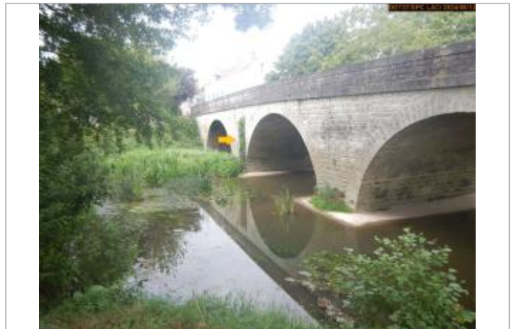
Vue du site en 2024, avec le repère de la crue de janvier 2018
