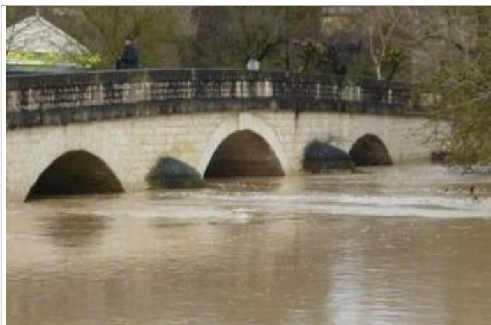
Photographie du pont pendant la crue, le 2 février 2013
