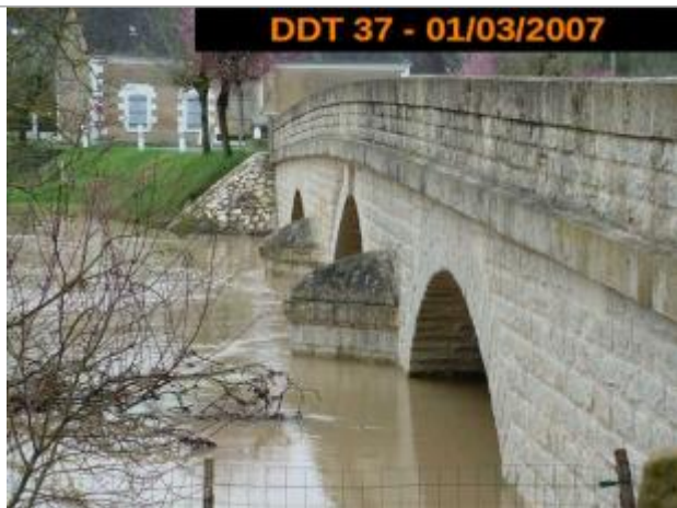
Photographie de la crue de mars 2007
