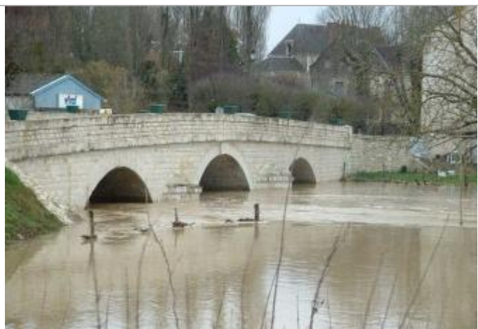
Photographie du pont pendant le crue, le 1er janvier 2002
