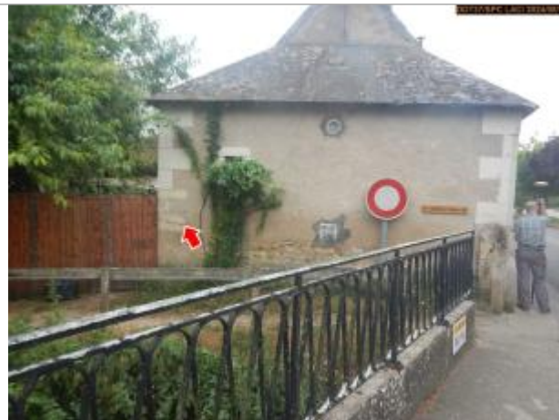
Vue du site en 2024, avec le repère de la crue de 2016
