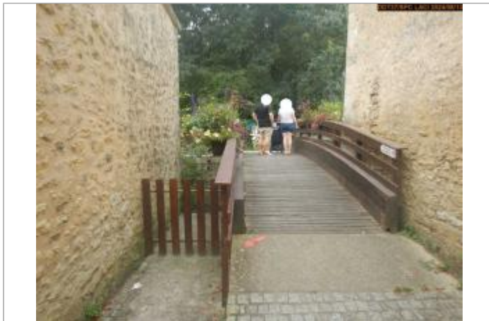
Vue du site en 2024, avec le repère de la crue de 2007
