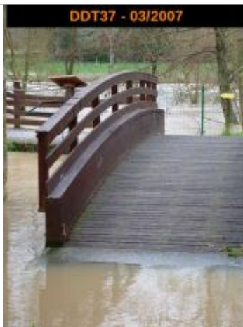
Photographie prise pendant la crue
