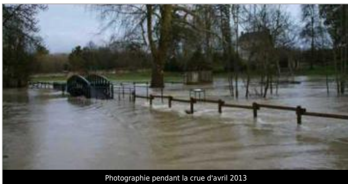
Photographie pendant la crue d'avril 2013
