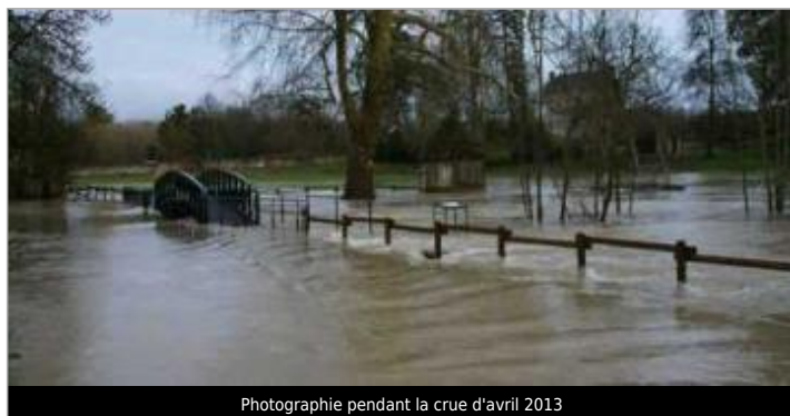
Photographie pendant la crue d'avril 2013
