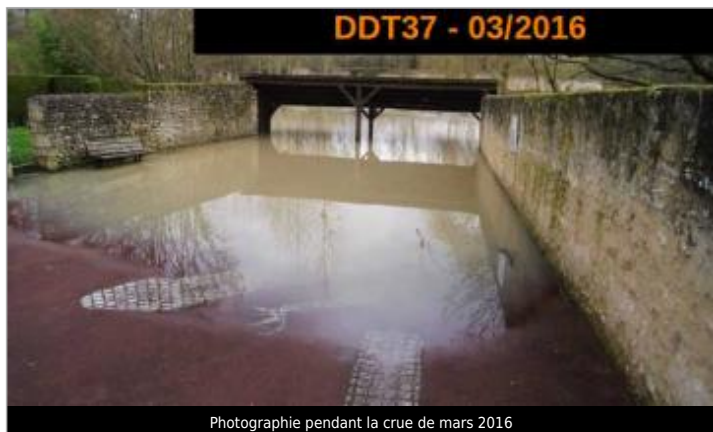
Photographie pendant la crue de mars 2016
