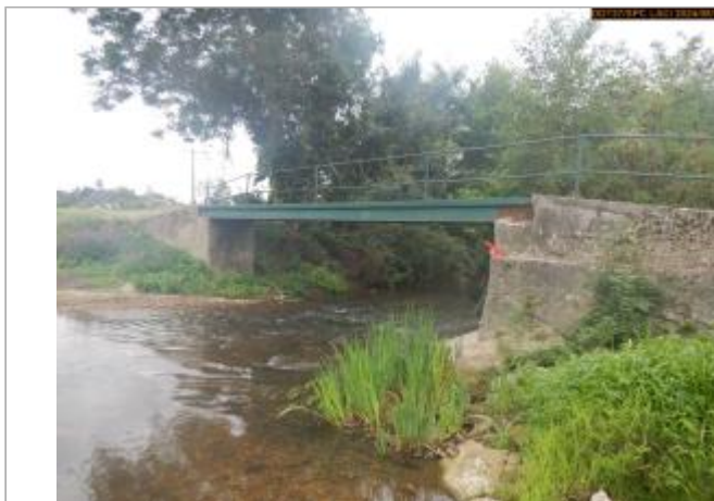
Vue du site en 2024, avec le repère de la crue de février 2013
