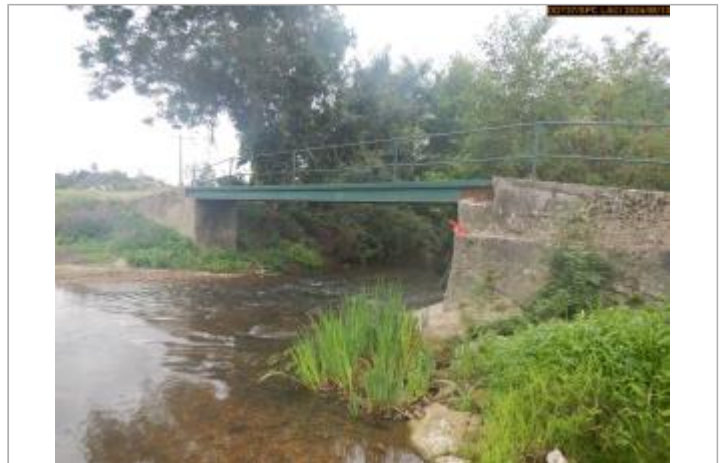
Vue du site en 2024, avec le repère de la crue de février 2013
