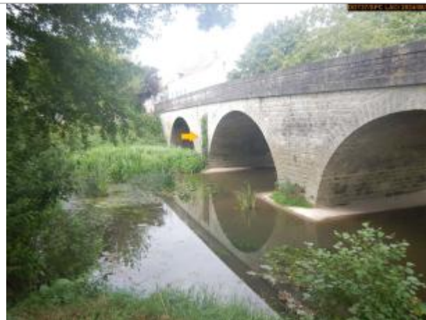
Vue du site en 2024, avec le repère de la crue de janvier 2018
