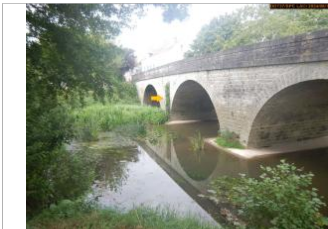
Vue du site en 2024, avec le repère de la crue de janvier 2018
