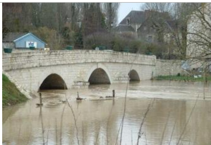
Photographie du pont pendant la crue, le 1er janvier 2002
