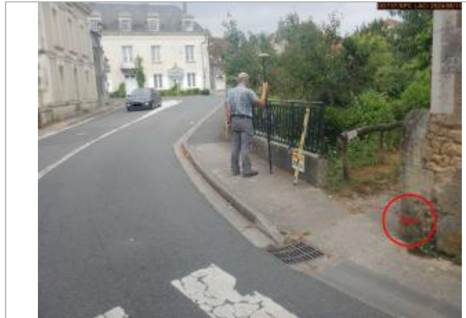
Vue du site en 2024, avec le repère de la crue de 2016
