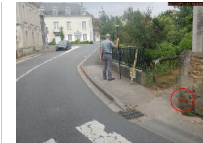
Vue du site en 2024, avec le repère de la crue de 2016
