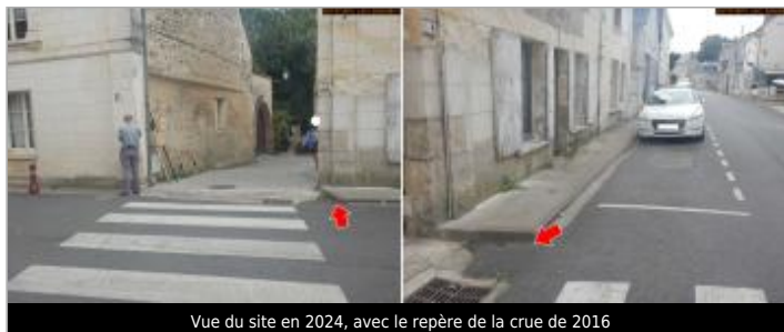
Vue du site en 2024, avec le repère de la crue de 2016
