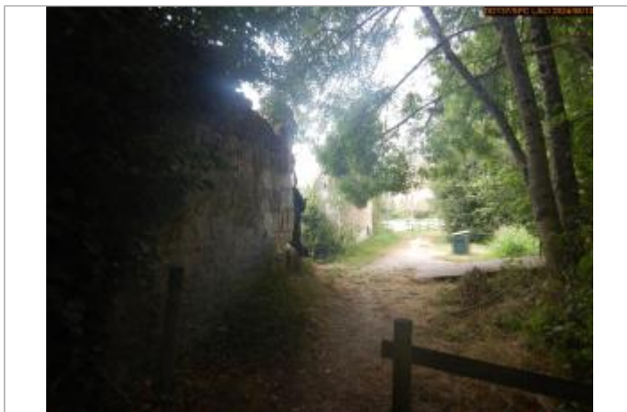
Vue du site en 2024, avec le repère de la crue de 1745
