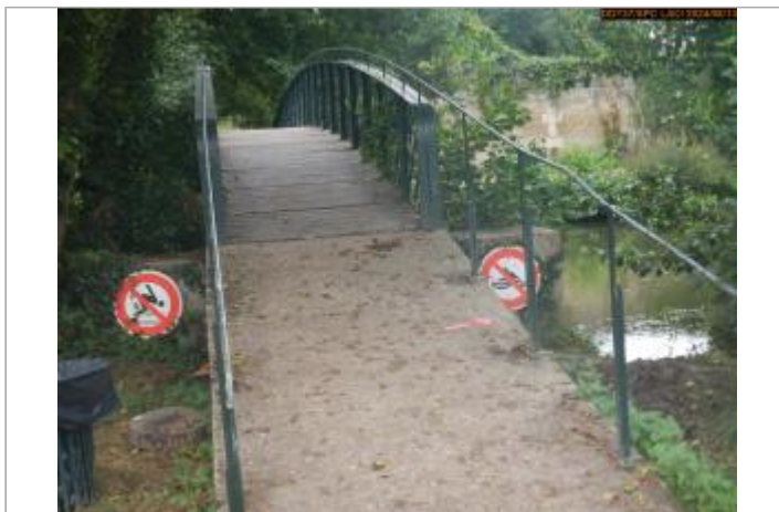
Vue du site en 2024, avec le repère de la crue de 2011
