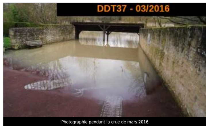
Photographie pendant la crue de mars 2016
