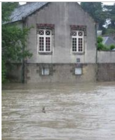
Photographie prise pendant la crue
