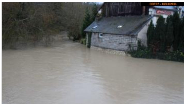
Photographie de la crue de 2011
