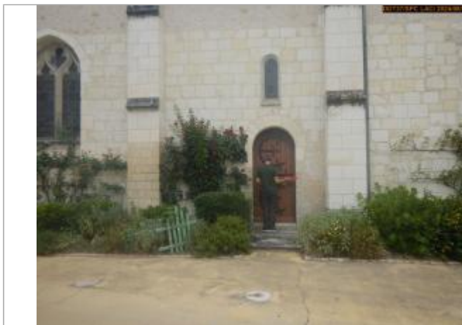
Vue du site en 2024, avec le repère de la crue de 1770
