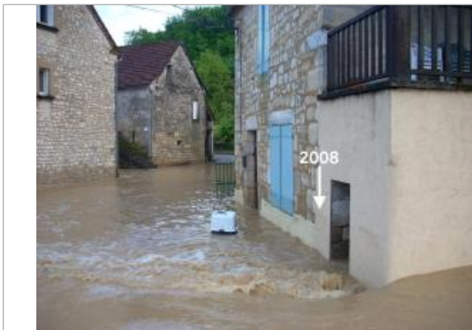
auteur photo : mairie - façade Ouest
