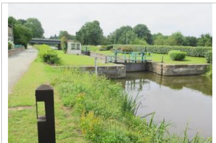
Vue générale de l'amont de l'écluse de Mons à Bruz
