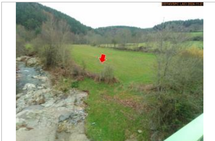
Vue du site en 2024 depuis le pont, avec le repère de la crue du 17 octobre 2024
