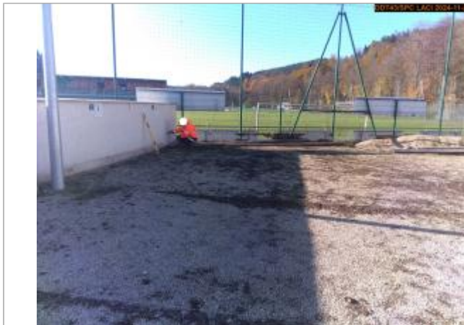
Vue du site en 2024, avec le repère de la crue du 17 octobre 2024
