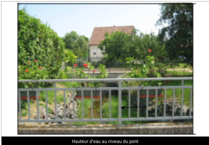
Hauteur d'eau au niveau du pont
