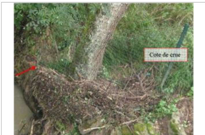
photo repère de crue
