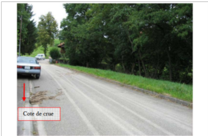
haut du trottoir de l'avaloir
