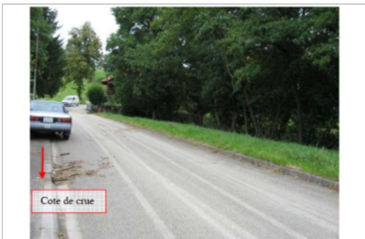
haut du trottoir de l'avaloir
