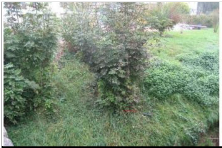
photo repère de crue
