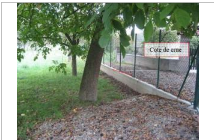
photo repère de crue
