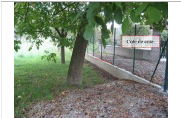
photo repère de crue
