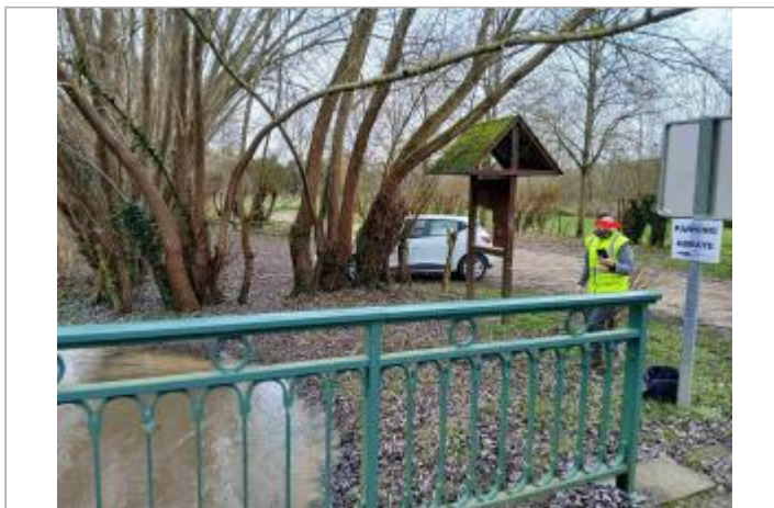
Ponton en bois au niveau du pont de la D714
