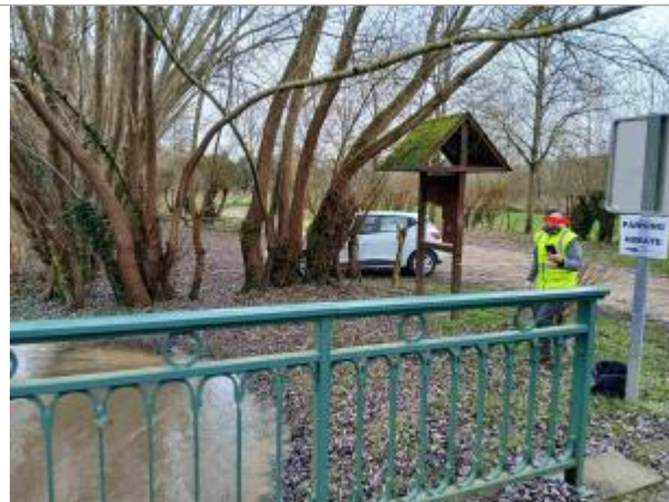
Ponton en bois au niveau du pont de la D714
